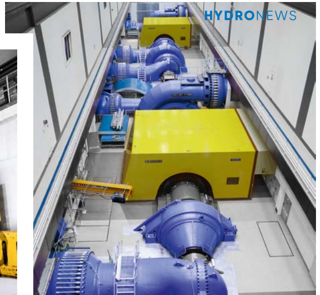
Avec ses quatre unités turbine-alternateur, Wehr est la plus grande centrale électrique du portefeuille de Schluchseewerk AG et fournit des services essentiels d'équilibrage du réseau.
