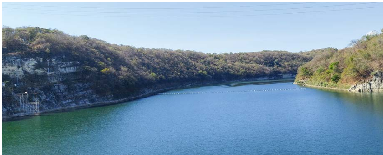
Réservoir d'Angostura depuis la prise d'eau
