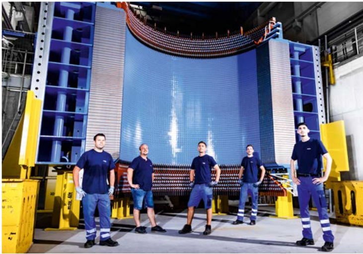
En étroite collaboration avec le client, l'équipe alternateurs d'ANDRITZ a installé en 2021 l'alternateur à moteur refroidi par air de l'unité B09.
