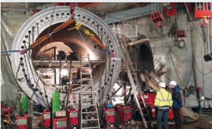
Die Hauptinstallationsarbeiten an der Druckrohrleitung, einschliesslich der Füllprobe, wurden im Mai 2015 abgeschlossen. Mehr als 9.100 Tonnen Stahl verschiedener Qualitäten und Dicken wurden verarbeitet und verschweisst. Die Arbeiten an der Verbindung vom alten zum neuen Druckschacht wurde von März bis April 2016 ausgeführt. Während dieser Zeit wurde auch die Dichtung an der Drosselklappe ausgetauscht.
