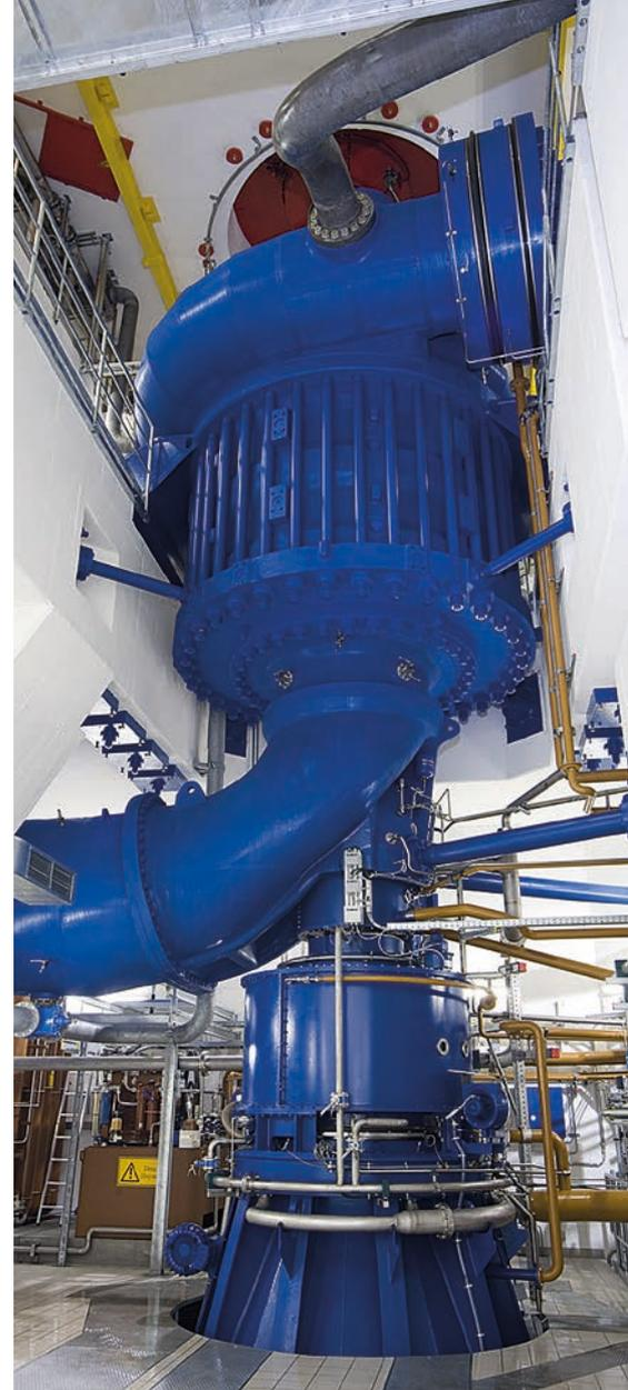
Pumpturbineneinheit mit vier Stufen
