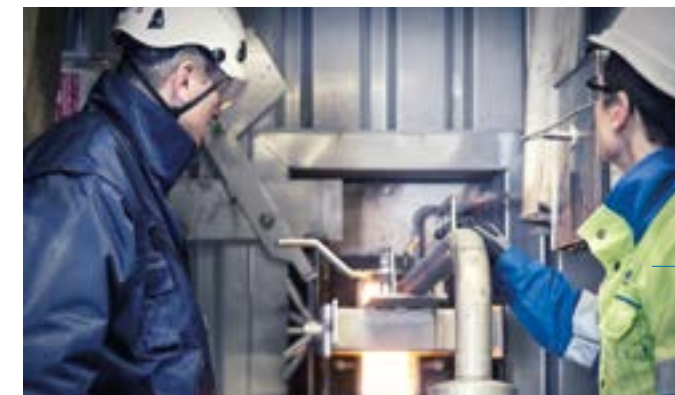
Горелки для сжигания щелока. Установка нового котла привела к снижению выбросов на 40–50 %.
